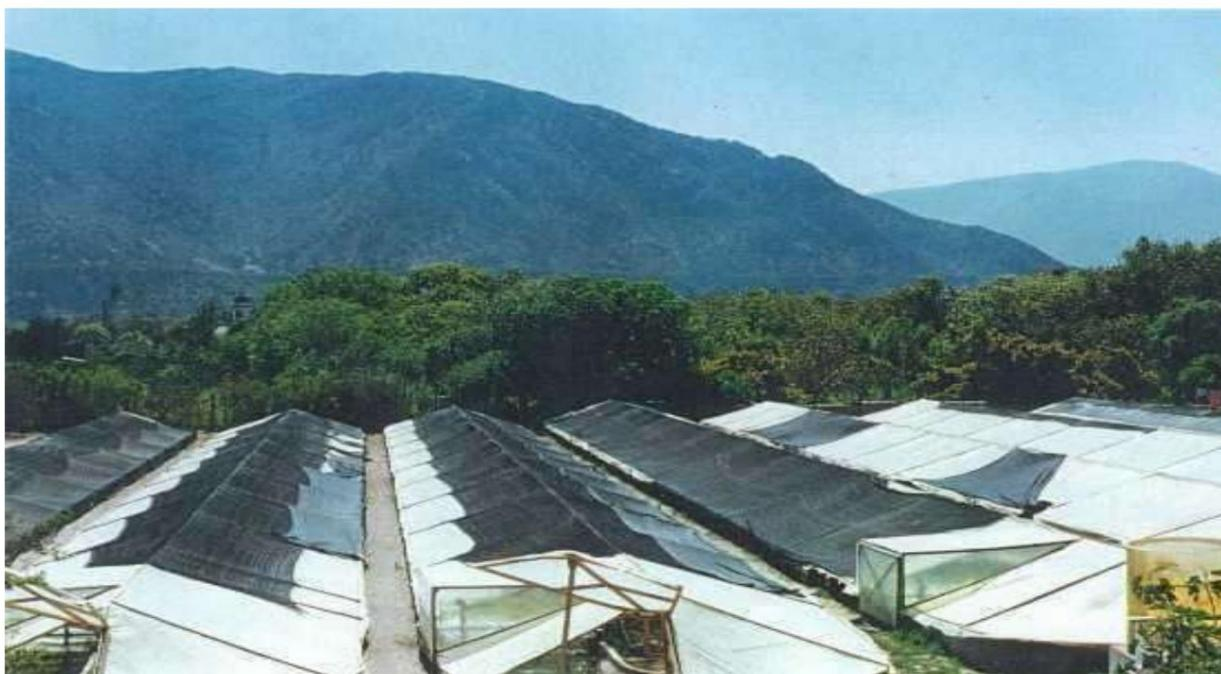
En Bionor, cerca de La Serena, Valle de Elqui (Chile), 1997: sólo los cabezales de las balsas son de cemento, el resto es de película semirrígida de etileno-propileno (extremo embebido en hormigón), los invernaderos tienen marco de madera
